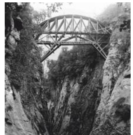
L'impalcatura del ponte - Introd, 1915 Autore Grat Éloi Ronc Arch. BREL - Fondo AVAS/Ronc-Ardisson
