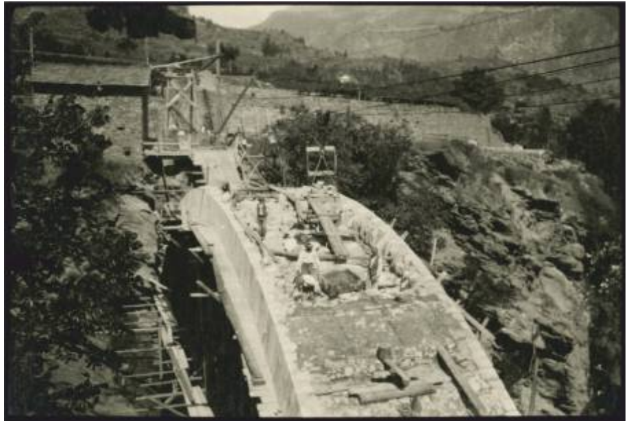
Trasporto dei blocchi di pietra sul ponte con l'ausilio di una carrucola Introd, 1916 - Autore Alberto Gonella - Arch G. Caracciolo di Brienza
