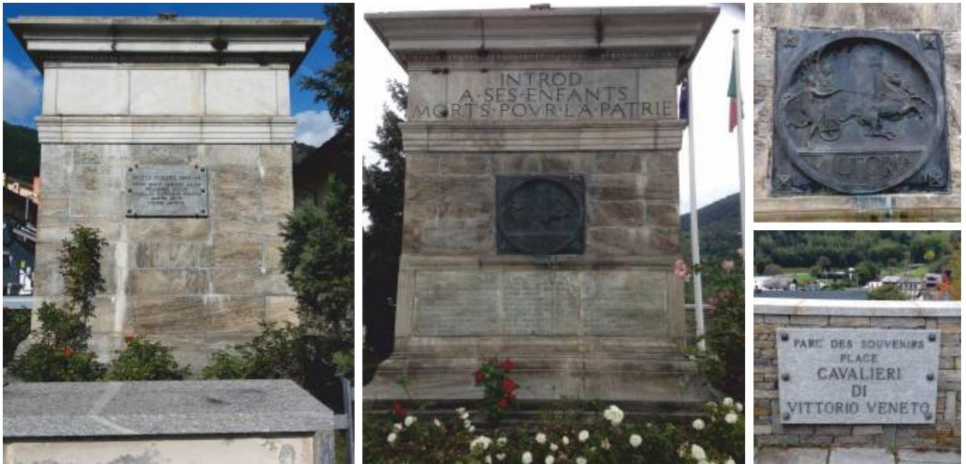
Il monumento prima del restauro
