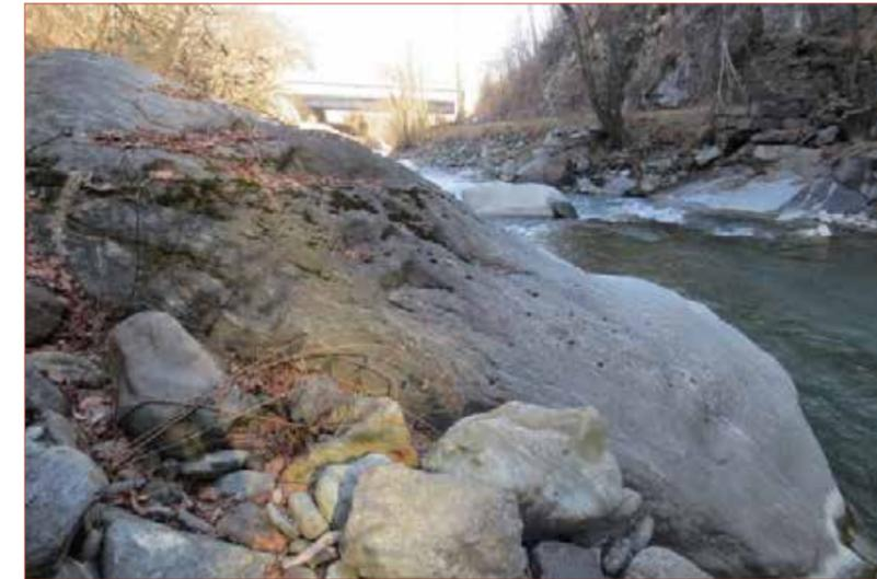
En cette photo, sont visibles : 1) le pilier sur la droite orographique (tout à droite). 2) le rocher plutôt blanc au milieu de la rivière, supportant la pile centrale du pont. 3) le rocher sur la gauche orographique, support de la deuxième pile du pont et servant, aussi, comme point d'appui pour la barrière (*rastellum*).
