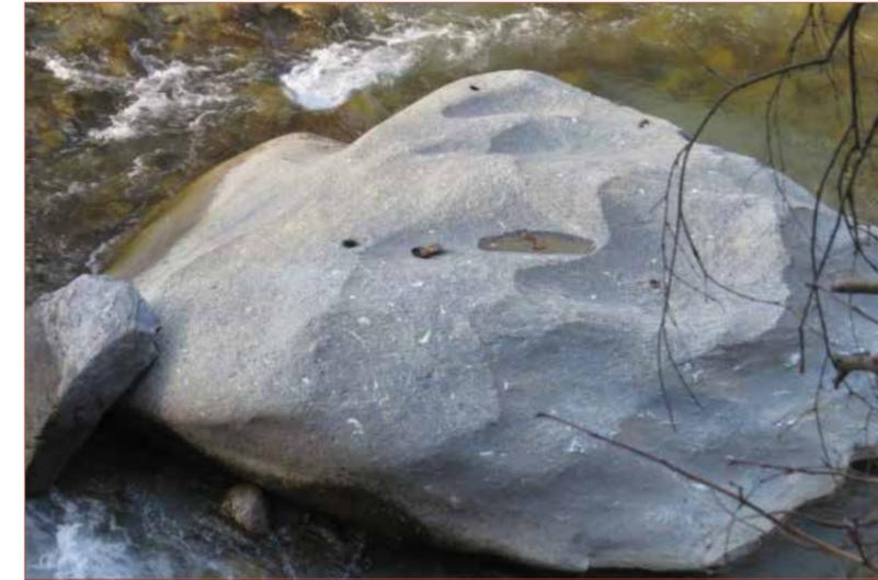
Ce rocher, gris clair, au milieu de la rivière, supportait la pile centrale du pont. Sont encore visibles les trous contenant des barres de fer plantées dans le rocher et servant à rendre plus solide cette pile.
