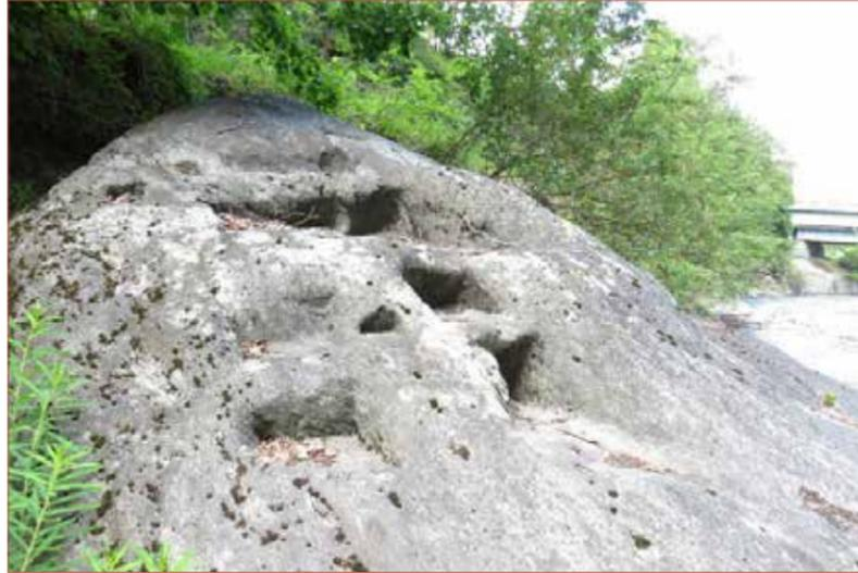
Sont encore bien visibles les «escaliers» creusés dans le rocher et servant comme points d'appui pour la barrière (rastellum) de protection du pont
