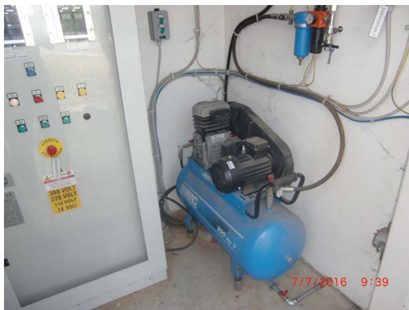
Compressore aria servizi dentro box in cemento
