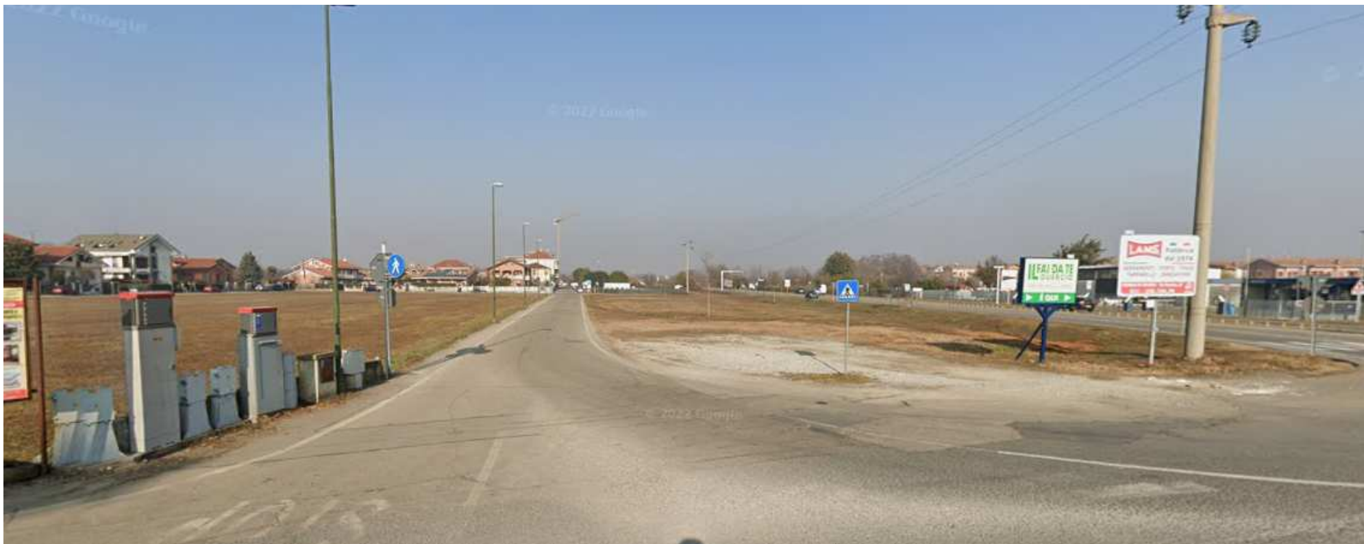
Vista dell'attuale innesto della Via Fenestrelle sulla Via Giaveno in prossimità della rotonda con la Via Circonvallazione
