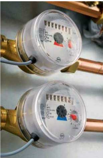
UNITA' DI SINGOLO ALLOGGIO - CONTA CALORE (riscaldamento/acs)
