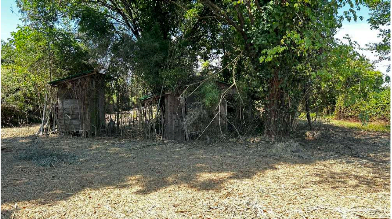
Foto delle strutture esistenti in stato di abbandono
