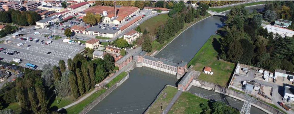
La chiavica del Canale Cavour
