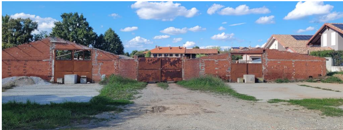
Figura 3 – Vista da SE verso NW dell'area LC3.
