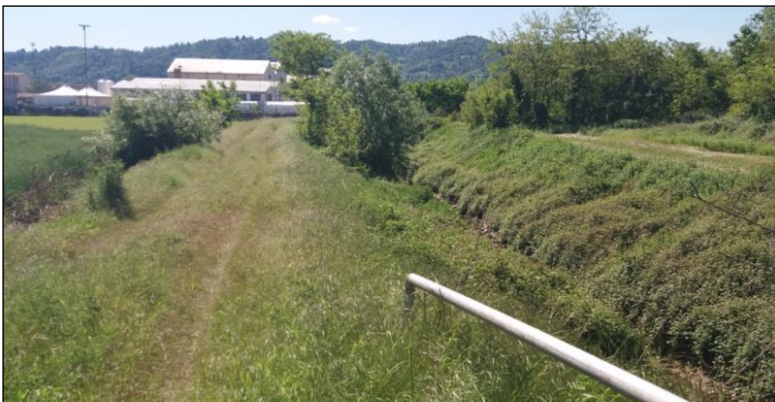
Figura 7 – Alveo del Rio Nuovo Orchetto con argini in terra a monte dello stabilimento ex Rivoira.
