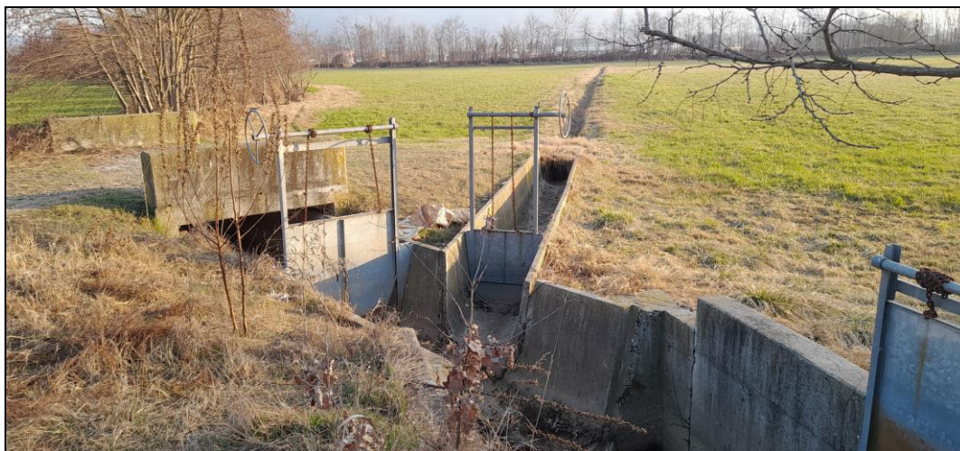
Figura 16 – Ripartizione delle acque di irrigazione immediatamente a valle della linea ferroviaria.
