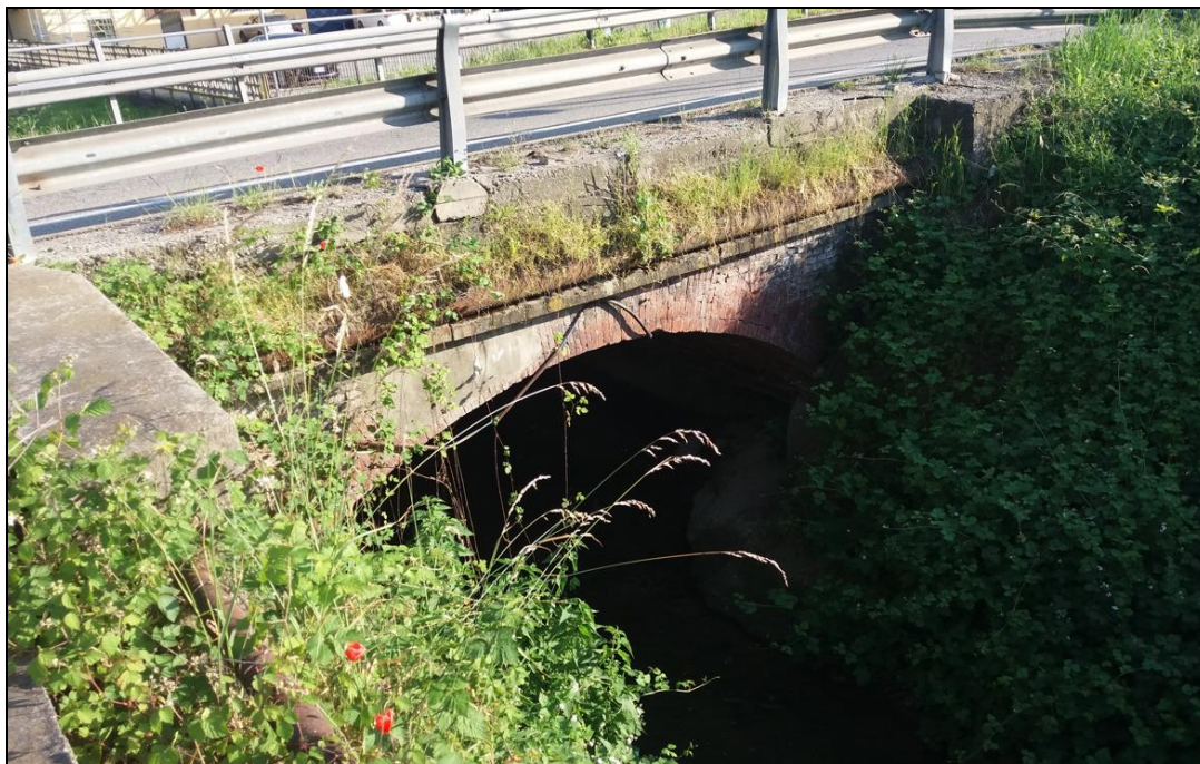
Figura 12 – Imbocco di monte dell'attraversamento della S.P. n. 11.
