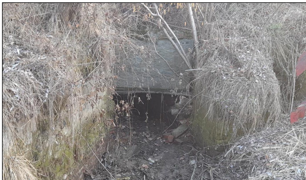
Figura 18 – Imbocco dell'attraversamento del corso d'acqua sotto la Roggia San Marco.
