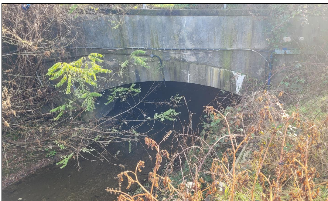
Figura 11 – Imbocco di monte dell'attraversamento ferroviario.
