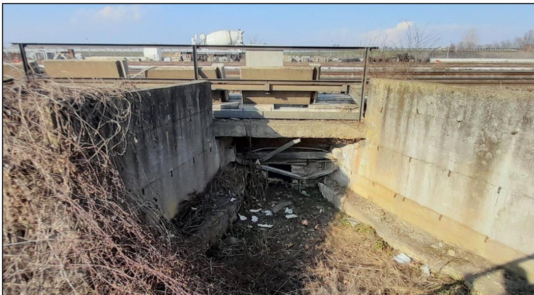
Figura 24 – Attraversamento ferroviario (“fornice” nella figura precedente) del Rio Orchetto.
