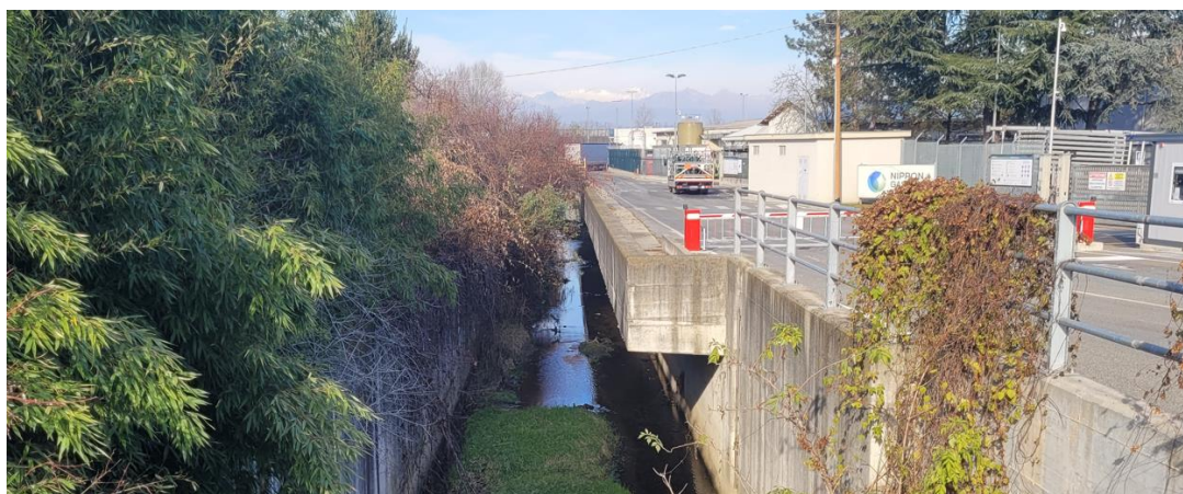
Figura 9 – Alveo canalizzato del Rio Nuovo Orchetto immediatamente a monte di Via Curie.
