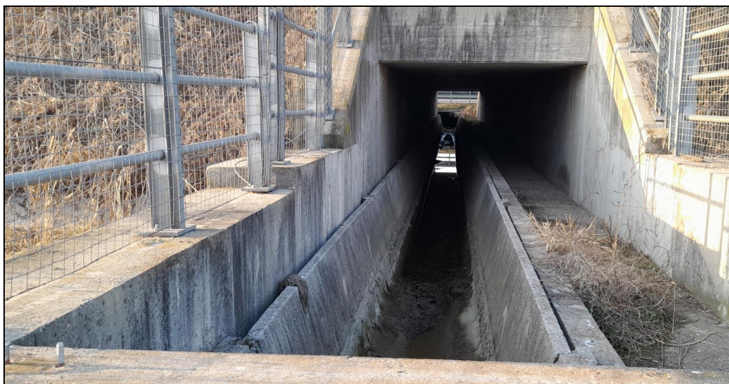
Figura 15 – Attraversamento dell'Autostrada TO-MI e della linea ferroviaria.
