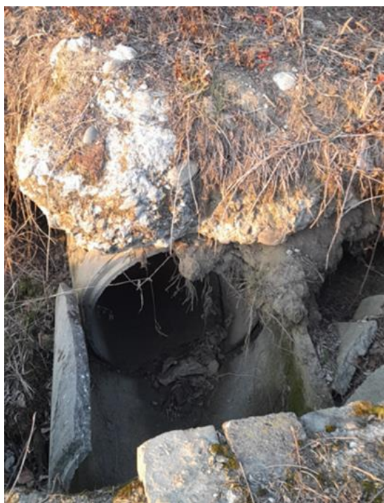
Figura 19 – Sbocco dell'attraversamento ( \phi 0,80 m) del Rio Orchetto immediatamente a valle della Roggia San Marco.
