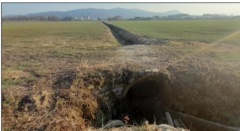
Figura 20 – Rio Orchetto a valle della Roggia San Marco e attraversamento strada campestre ( \phi 1,20 m).
