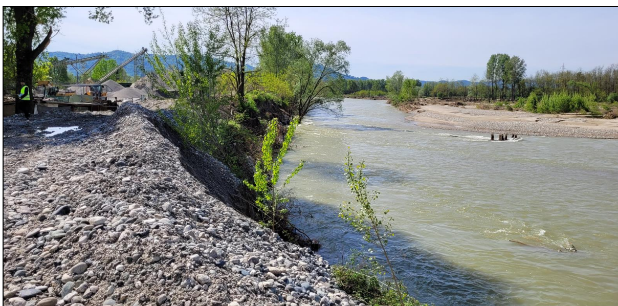
Foto 3 e 4 – Erosione del T. Orco in sponda sinistra immediatamente a Sud di Pratoregio.
