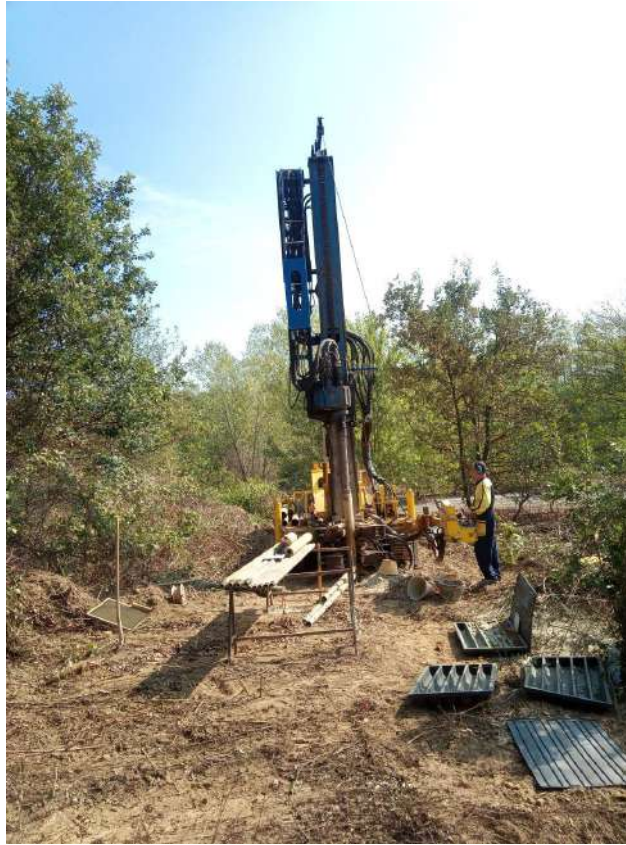
Posizionamento sondaggio S6Pz
