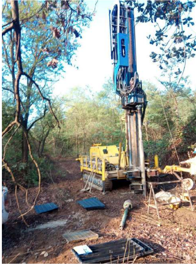
Posizionamento sondaggio S9Pz
