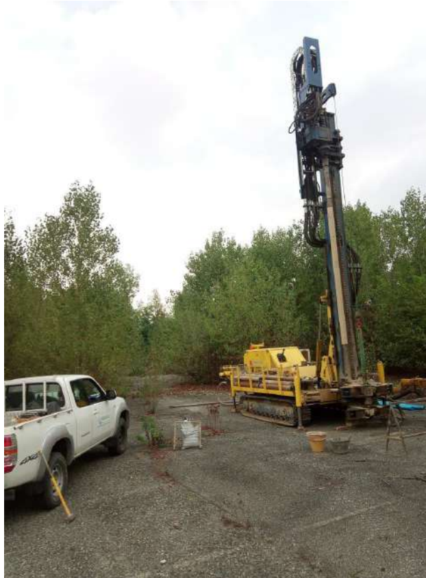
Posizionamento sondaggio S1Pz
