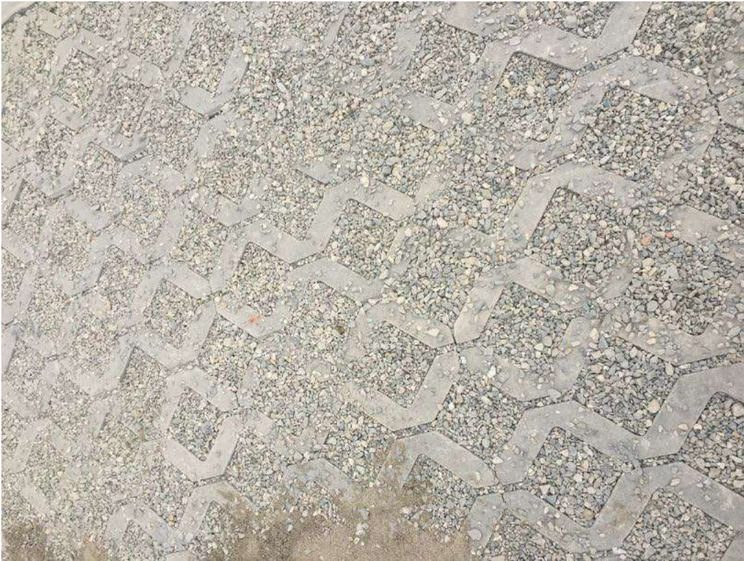
FOTO DI PAVIMENTAZIONE CON AUTOBLOCCANTI INGHIAIATA APPENA REALIZZATA
