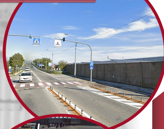
6 Tratto di ciclopedonale a ridosso del muro perimetrale del Consorzio Pichi
