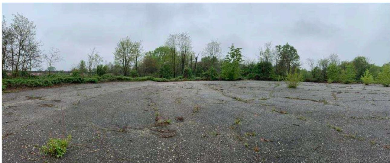
FIGURA 13 FOTO DEL PIAZZALE CON ROTTURE DELLA PAVIMENTAZIONE
