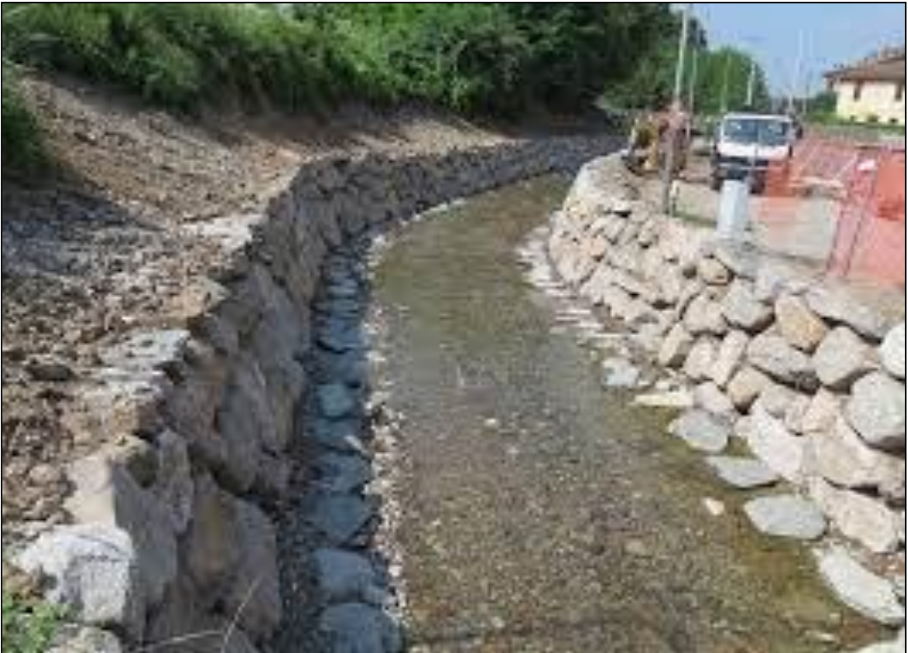
Esempio di scogliera in massi in fase di esecuzione: in questo caso, l'analogia è la presenza della fondazione
