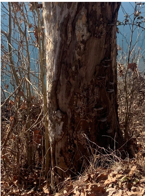
Albero di Platanus sp. con difetti gravi: ampia lesione sul colletto e sul fusto e presenza di carpofori di funghi saprofiti.
