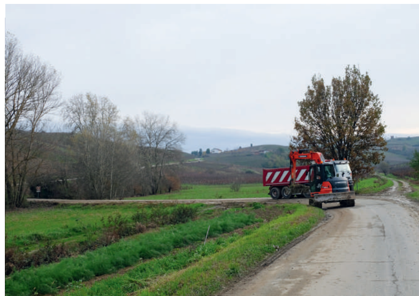
Figura 221: manutenzione dei fossi a Maranzana
