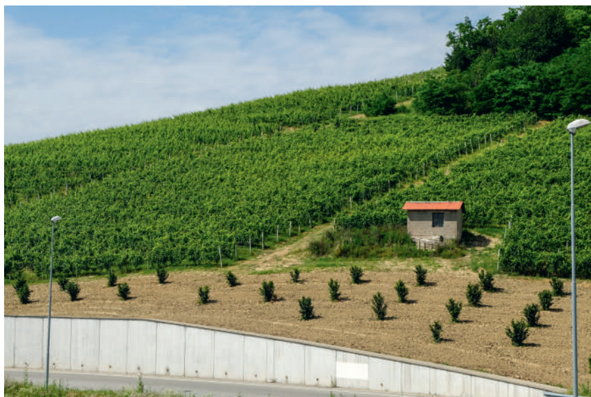
Figura 58: strada statale 456 ad Isola d'Asti
