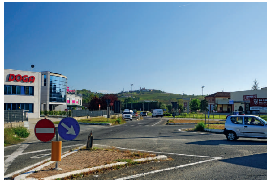
Figura 59: strada statale 456 a Montegrosso
