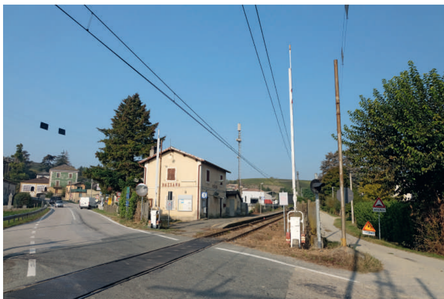
Figura 65: stazione ferroviaria a Mombaruzzo
