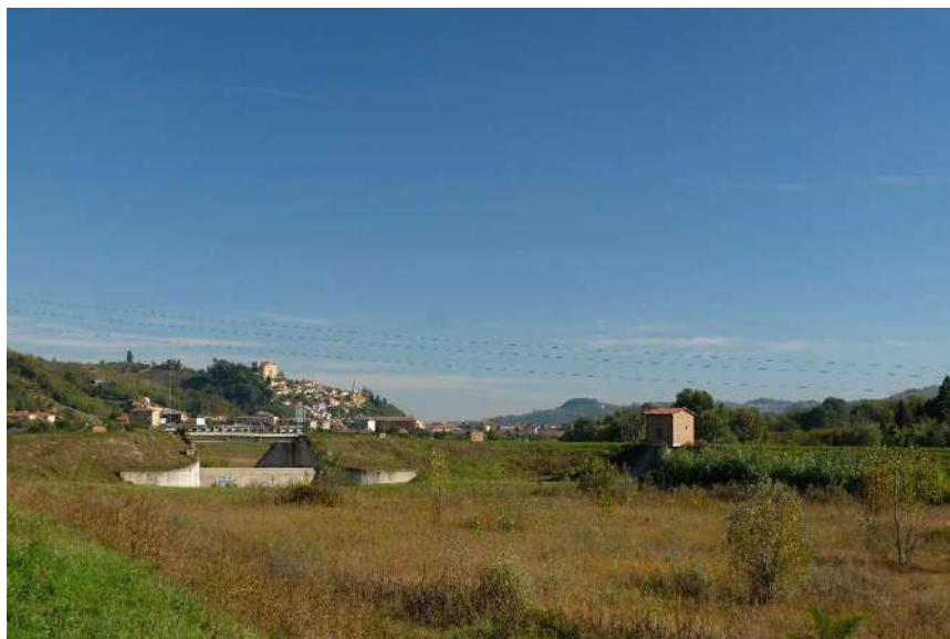
Figura 54: casse d'espansione del Belbo a Canelli
