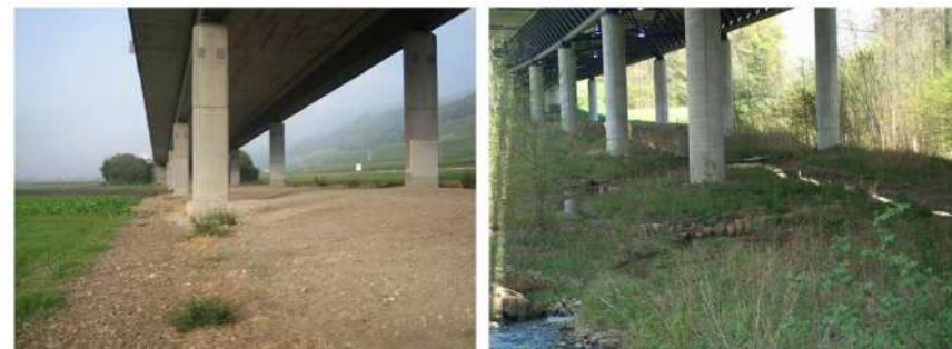
Figura 254: esempio di viadotto senza nessuna mitigazione a sinistra, e con mitigazione a destra (foto di Trocme 2006)
